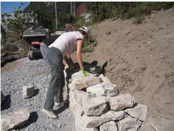
Eine Trockensteinmauer ist eine Mauer, die ohne Mörtel oder andere Bindemittel gebaut wird. Damit die Trockenmauer stabil und beständig bleibt, werden verschiedene Steintypen verwendet und so angeordnet, dass sie ihr Gewicht und ihren Druck auf gleichmäßige Weise verteilen.
