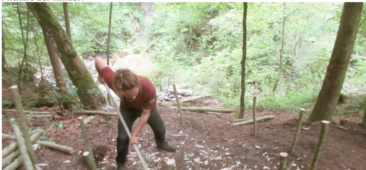
Abbildung 9: Ausebnen des Waldsofabodens (G.F., 2015)
