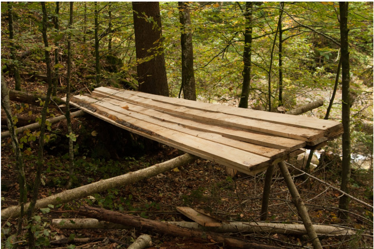
Abbildung 14: Das erste Bauholz für das Dach wurde transportiert (G.F., 2015)
